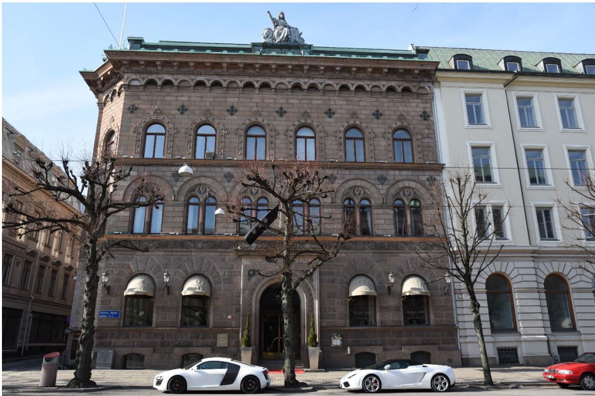
Sveahusets fasad mot Västra Hamngatan 3.
